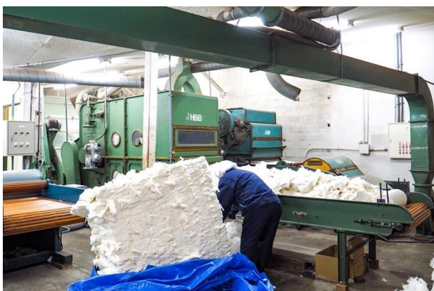
写真1 第一工場の混打綿機
